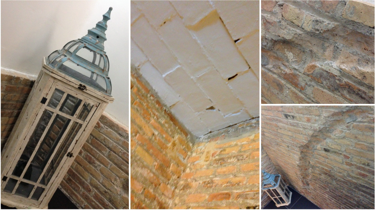
Detalle de techos y muros
