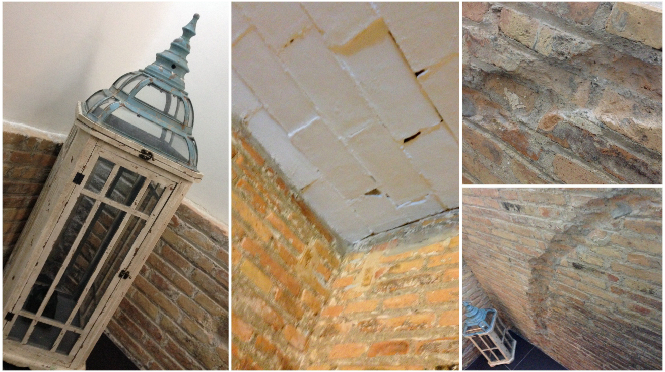
Detalle de techos y muros
